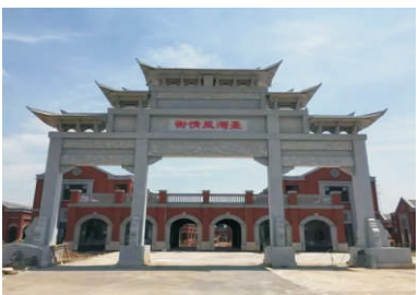
南京桥林陡岗新市镇-IP网络广播系统
