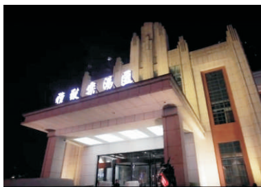
鞍山立山区雅致乐汤汇会馆-智能广播系统
