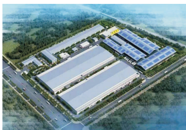
银川乐叶光伏科技-IP网络广播系统
