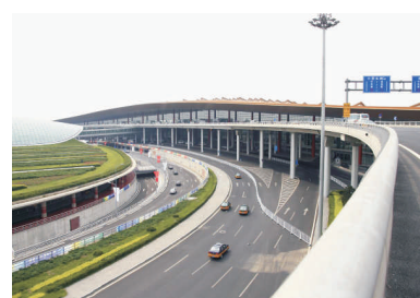
首都国际机场3号航站楼-智能广播系统
